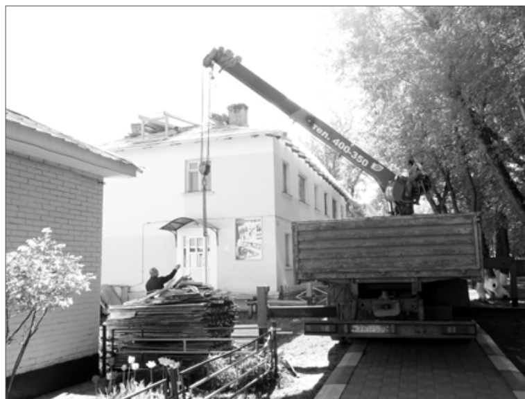
Ремонтные работы на доме по ул. Советская, 95.
