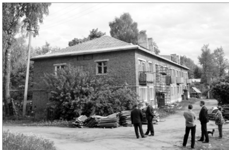
Депутатская комиссия проверяет ремонт крыши на доме по ул. Освободителей, 4.
