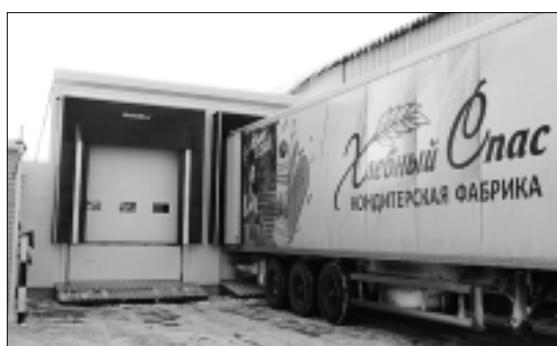
дах установлены новые двери – герметизаторы проемов. В складе готовой продукции теперь отдельная проходная с раздевалкой. Здесь же оборудован погрузочный пункт с возможностью одновременно вести погрузку продукции в два фургона. В помещении склада изготовлены гладкие полы и установлены трехъярусные стеллажи для паллет.
