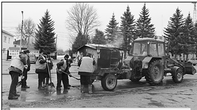
Бригада дорожного подразделения на ямочном ремонте дороги по ул. Советская.
