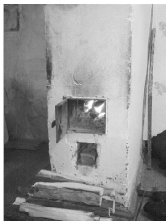
С наступлением осени в Калужской области увеличилось число пожаров, связанных с нарушением правил пожарной безопасности при монтаже и эксплуатации печного отопления. Основные причины пожаров - недостаточность расстояния между печью и стеной, несоблюдение параметра высо-
