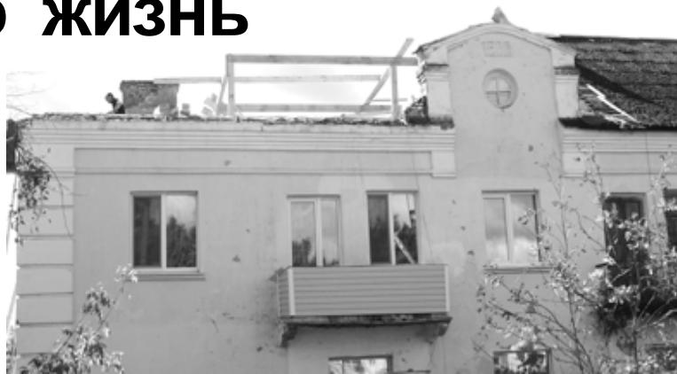
щий специалист администрации ГП «Город Спас-Деменск» Р. В. Фитисов, строители полностью разобрали старую крышу и установили новую конструкцию из бруса, а также стропила, обрешетку, сделали гидроизоляцию, потом утепление и пароизоляцию, оштукатурили и покрасили вентиляционные трубы, установили на них металлические колпаки. В завершение крышу покрыли металлической кровлей. Смотрится красиво, а главное - теперь не будет протечек в квартиры.
