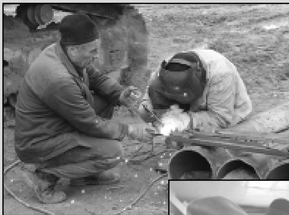
Сварщик Николай Котов и бульдозерист Александр Власов участвуют в ремонтных работах на заводе.
