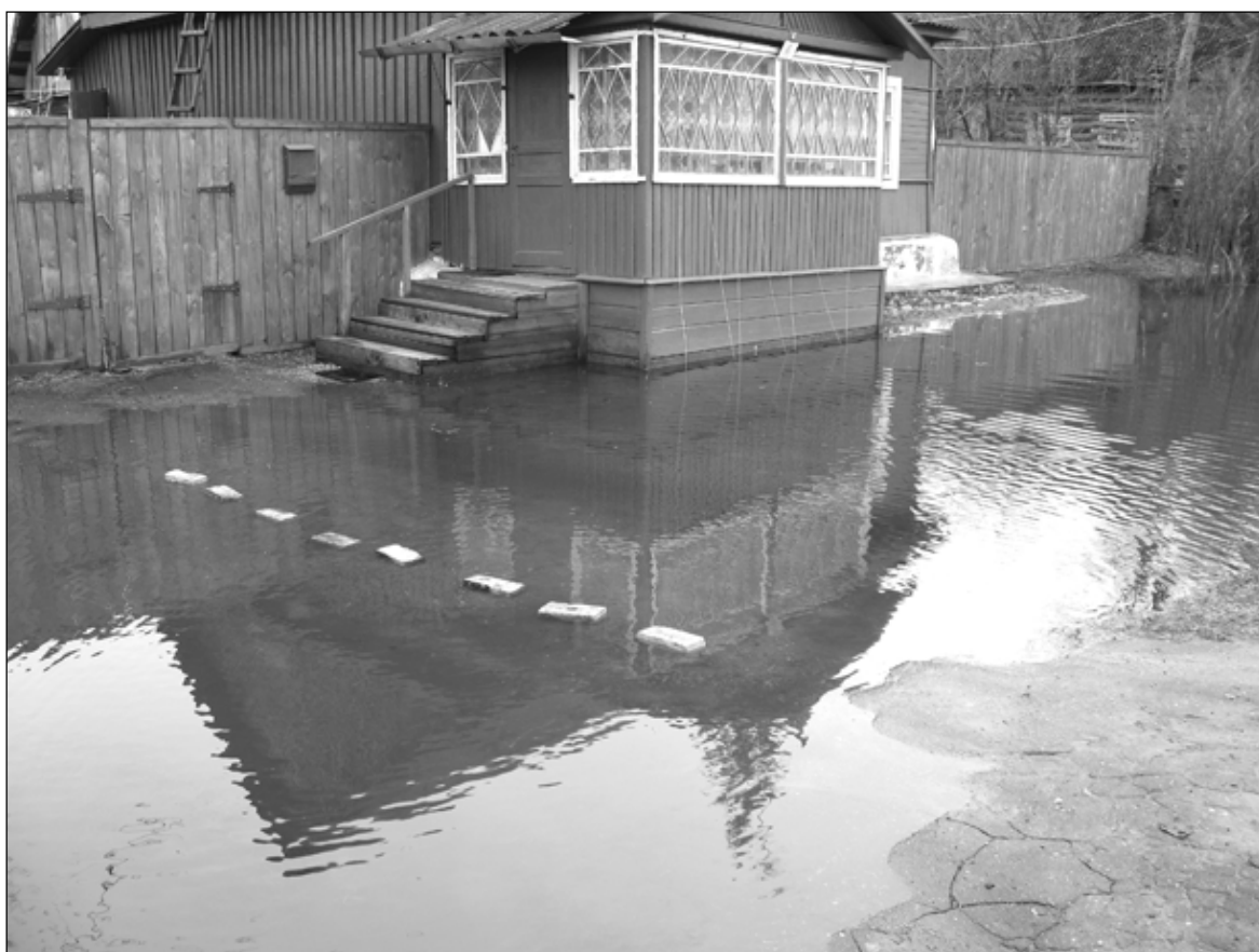
Без резиновых сапог домой не попадешь. Дом № 4 по ул. Соловьева.
