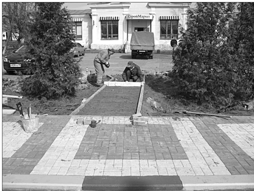
Продолжается работа по строительству тротуаров из плитки.
