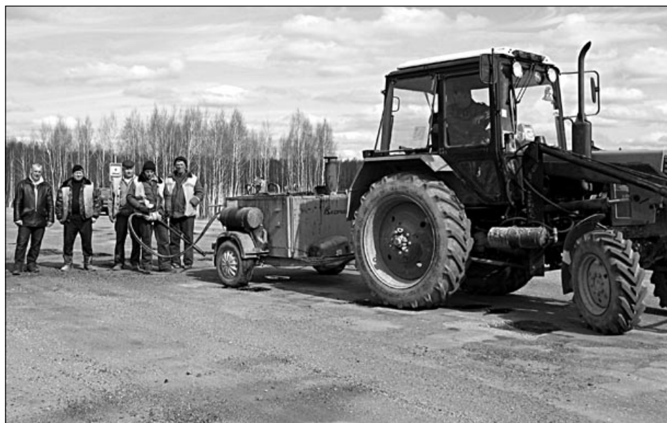
Дорога на Спас-Деменск: сначала ямочный ремонт, потом капитальный.
