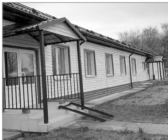
СДК после ремонта.
