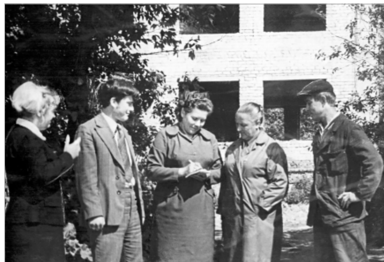
Строительство д/с «Рябинка».
