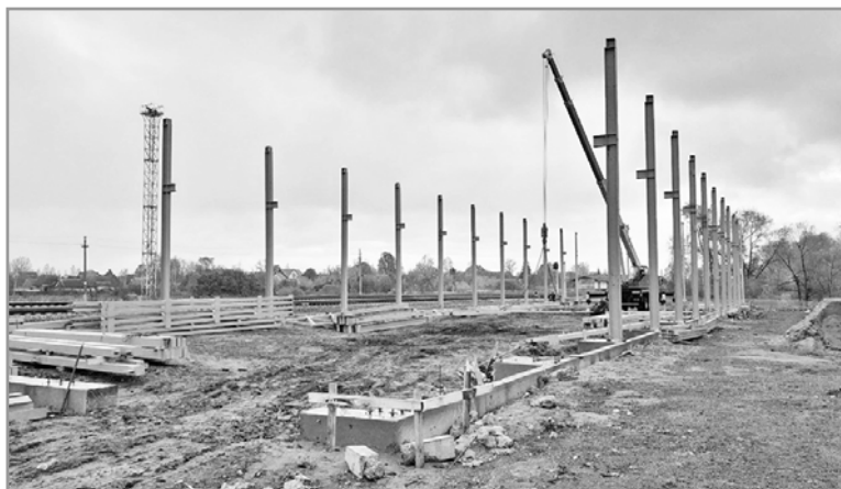
В этом году началось строительство цеха Спас-Деменского обособленного подразделения ООО «ПЭМРО».
