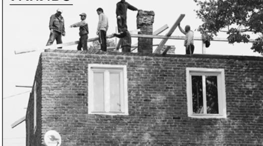
питаны специальным огнезащитным составом. На доме №14 крыша полностью снята, и теперь строители ведут установку новых стропил (на снимке). Вокруг дома светлыми пятнами выделяются штабеля бруса, досок. Работает бригада быст-
